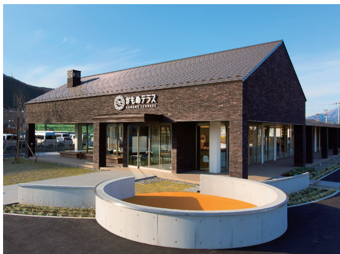
かもめテラス外観
