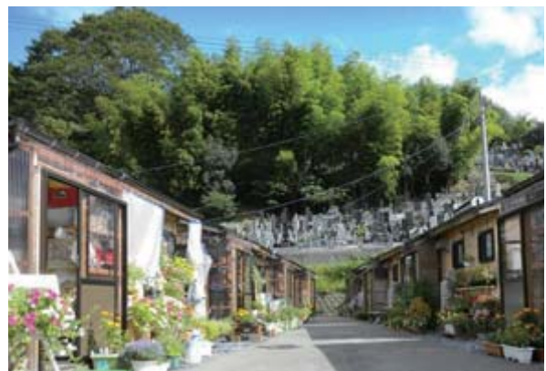
全国初となる応急木造仮設住宅
