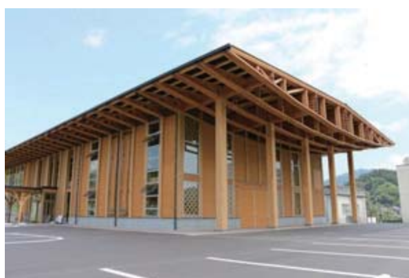
住田町役場の木造新庁舎
